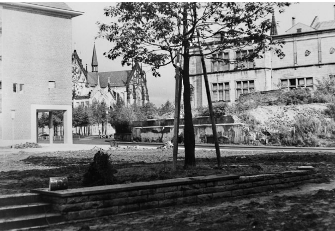
Landesmuseum als Teilruine, baulicher Zustand 1955
